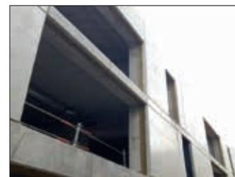
Exemple de mur sandwich à forte inertie, constituée d'une épaisseur importante à l'intérieur (inertie), d'un isolant thermique performant (R=5 m²KW minimum) et d'un parement massif extérieur (bouclier thermique).
