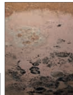
Exemple de développements fongiques liés à un excès permanent d'humidité. La combinaison température basse + forte hygrométrie + substance nutritive (cellulose, sucre...) favorise les développements fongiques.
